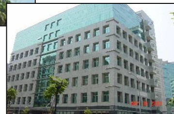
是方電訊雲端資料中心 麗源大樓 / 宏鼎大樓
